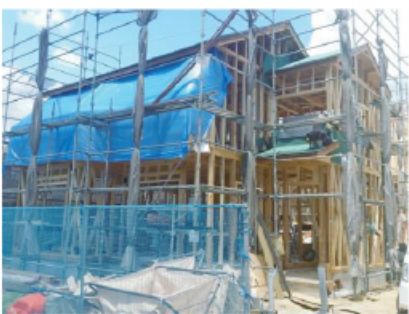
2号棟建築中写真(2015年7月撮影)
